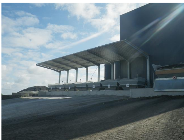
Figure 5 : quai de chargement et trémies doseuses sur une installation similaire
