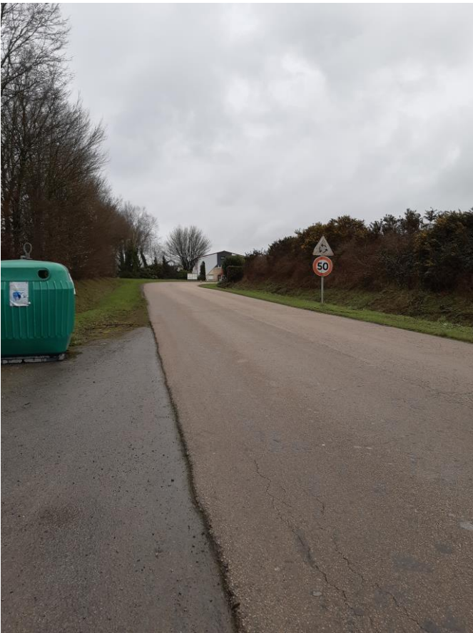
Photo 2 : Voie d'accès en direction de la ZA de Kerhervé
